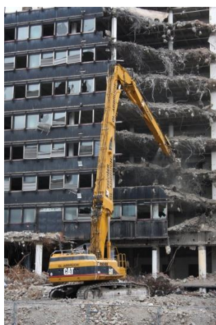
Рис. 1. Проведение демонтажных работ механизированным способом
