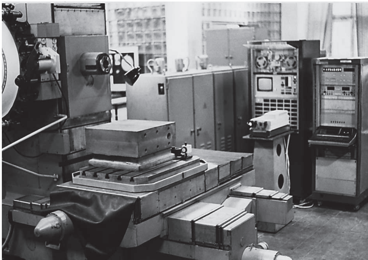
Общий вид первого отечественного измерительно-вычислительного комплекса (ИБК) для контроля точности станков на базе ЛИС ИПЛ-10М52 (1983 г.)
