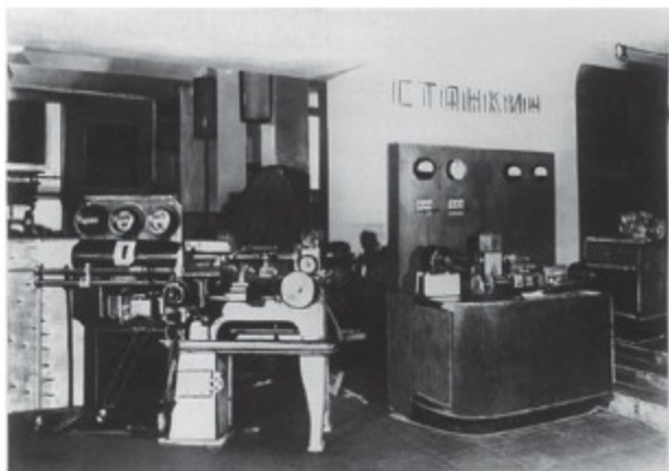
Стенд Станкина на Всесоюзной выставке по рабочему изобретательству в здании Политехнического музея в Москве, 1935 год. Слева револьверный станок с электропрограммным управлением. Справа первый в мире электроопорный станок, работающий по чертежу
